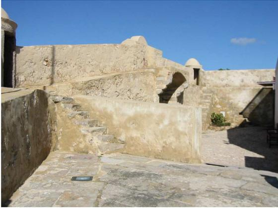
Fig. 1 - Reboco novo inadequado em Forte do séc. XVII da zona de Lisboa
