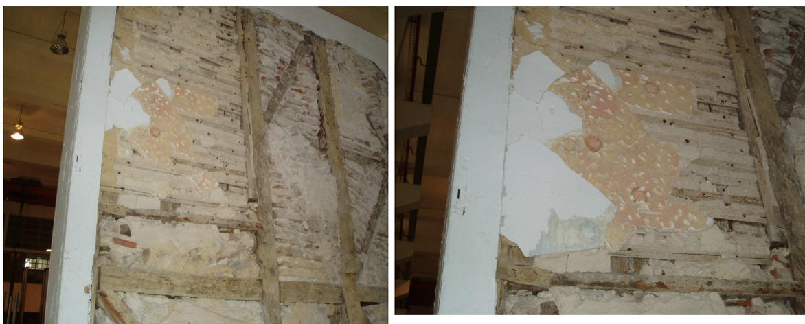
Fig. 8 - Parede Pombalina (séc. XVIII-XIX): pormenor do revestimento em várias camadas
