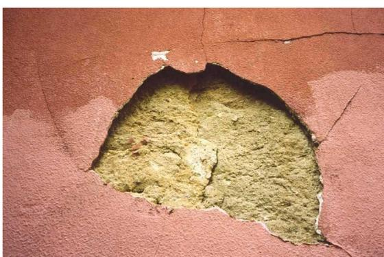
Fig. 6 - Camadas de acabamento de substituição de cimento: destacamento e degradação da base
