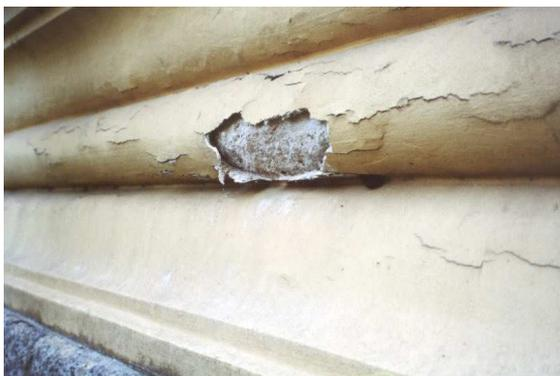
Fig. 5 - Palácio brasileiro do séc. XIX e edifício em Lisboa: repintura com membrana com degradação
