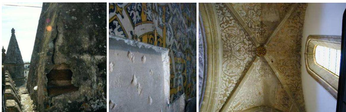
Figura 15 – Locais de amostragem das argamassas da Sé de Elvas. Da esquerda para a direita: pináculo (SEL 1), camada subjacente ao assentamento de azulejos (SEL 2), tecto da nave central (SEL 3).
