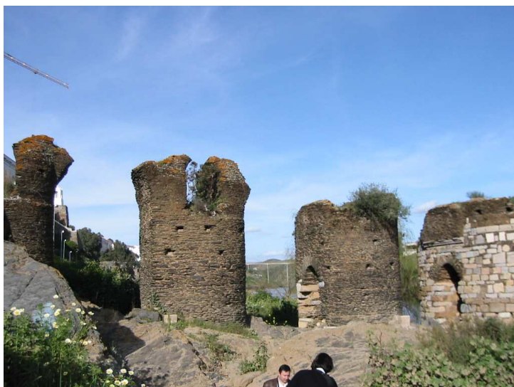
Fig.7 – Torre do Rio (Mértola)
