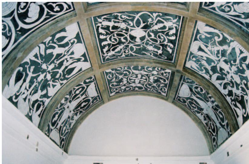
apresentava uma maior resistência, pois tinha-se expandido para o interior do reboco, o que requereu uma acção mais directa e prolongada através da aplicação do biocida em compressas de pasta de papel, sob as quais foi colocado um plástico negro, opaco, de modo a inibir o contacto com a luz, diminuindo assim o processo de fotossíntese.
